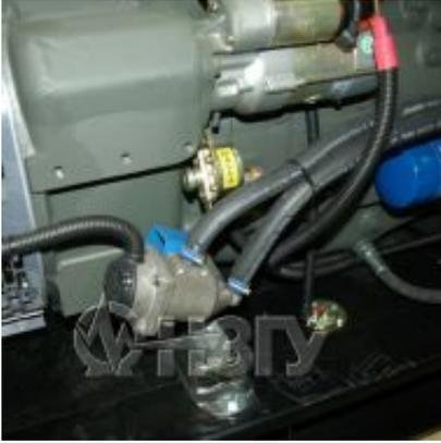
модель: **Подогреватель электрический СЕВЕРС-М 1,0 кВт**
